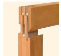
Le mode d'assemblage à double enfourchement collé sur ouvrant (assemblage mécanique sur dormant)
